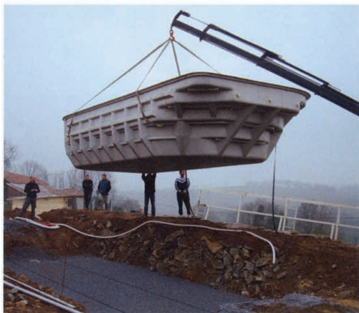
Après la pose du radier, la piscine coque est livrée et prête à être installée. Excel Piscines
